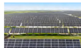
白城领跑者100MW项目
