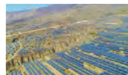
山西芮城领跑者基地 130MW海泰独家供应
