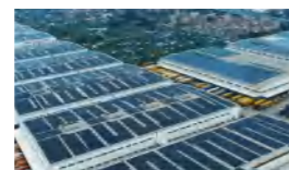
广东能源佛山20MW 物流园屋顶
