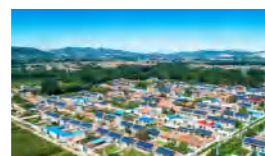
河北光伏+煤改电2MW
