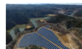
日本 千叶县2.3MW
