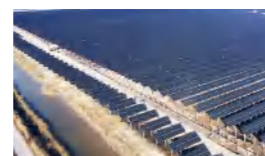
滨州260MW渔光互补项目
